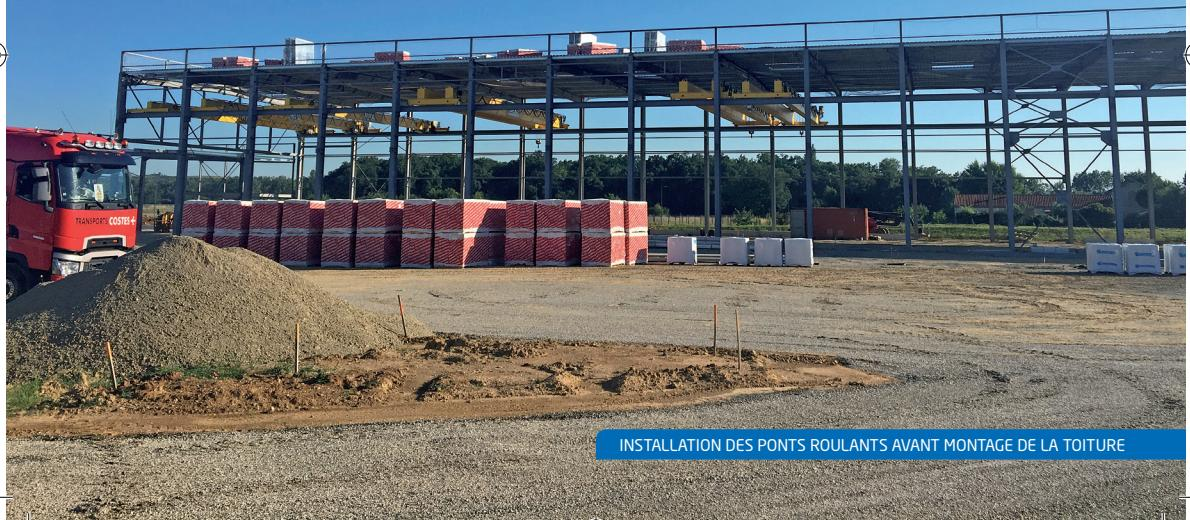
INSTALLATION DES PONTS ROULANTS AVANT MONTAGE DE LA TOITURE
